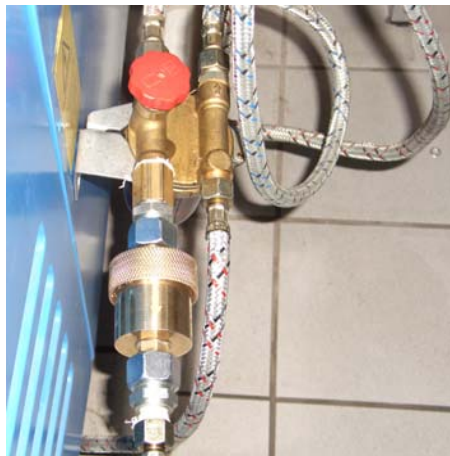
Abbildung 4: eingebauter HTKC – Hochtemperaturkeramikchip
